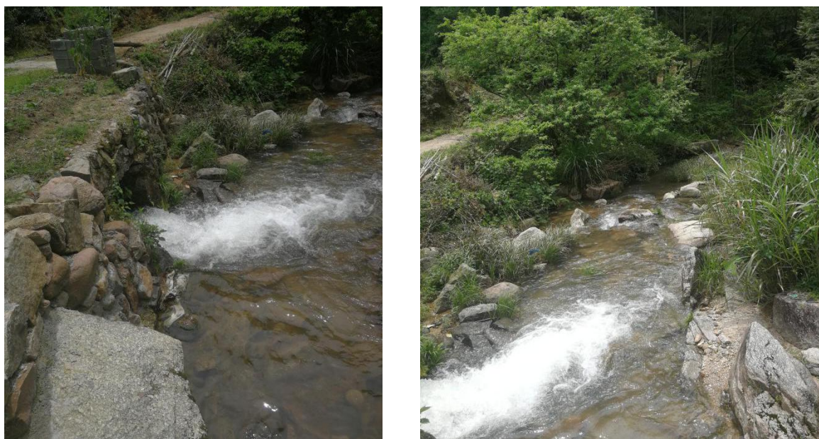
图5-3 项目尾水排放渠道
