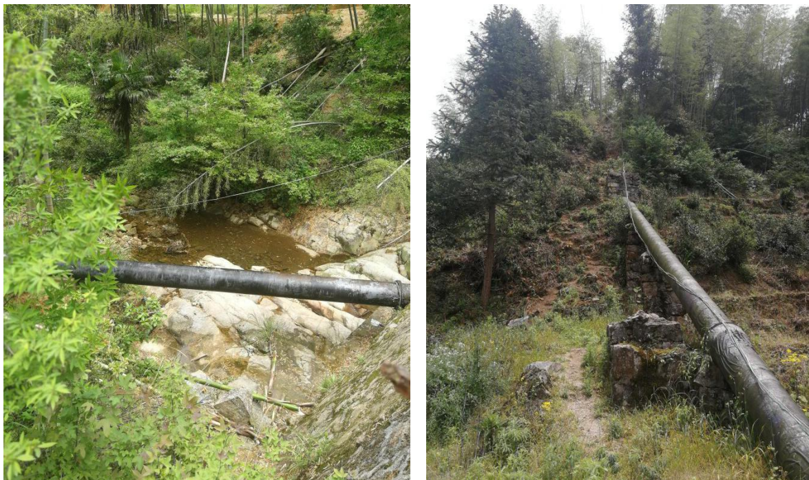
压力管线恢复情况
