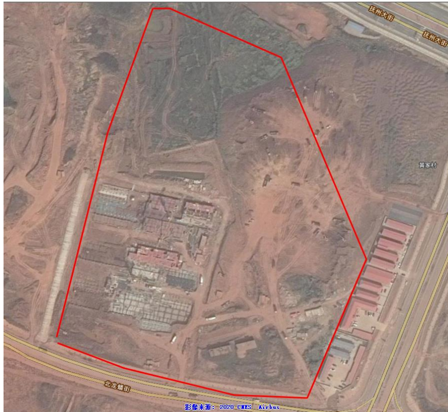
2015 年 10 月项目施工过程中扰动范围遥感影像
