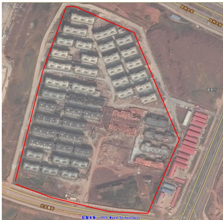
2016 年 9 月项目施工过程中扰动范围遥感影像
