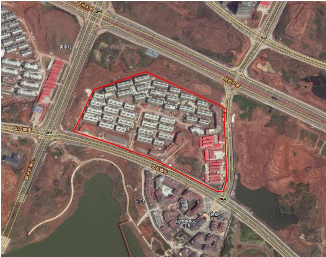
2018 年 9 月项目施工过程中扰动范围遥感影像
